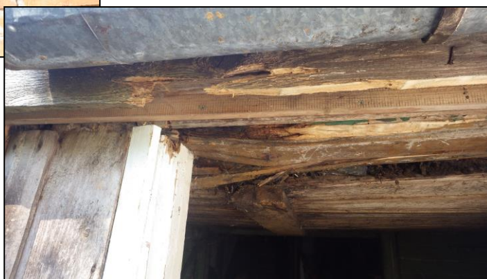
<12> 4. att. ▶ Ieejā griestu konstrukcijas draud iegrūt
