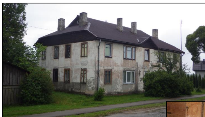
◀ <09> 1. att. Ēkas kopskats no ziemeļrietumiem
