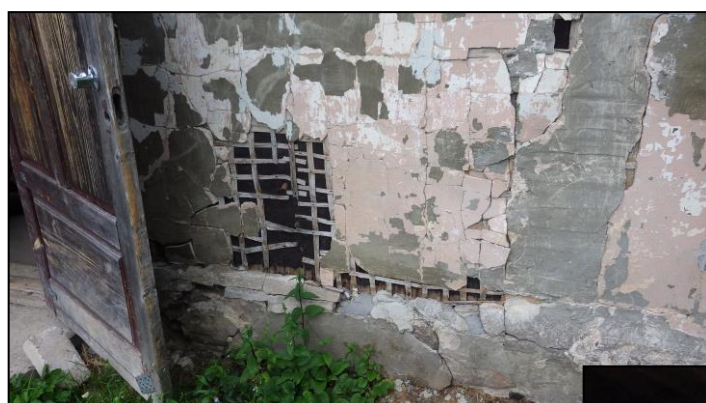
◀ <09> 3. att. Fasāžu apdares stāvoklis un izpildījums
