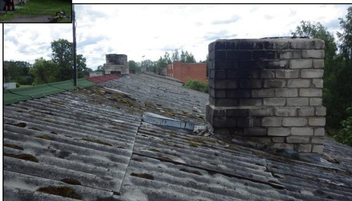
<02> 2. att. ▶ Jumta segums (azbestcimenta loksnes) stipri nolietojies
