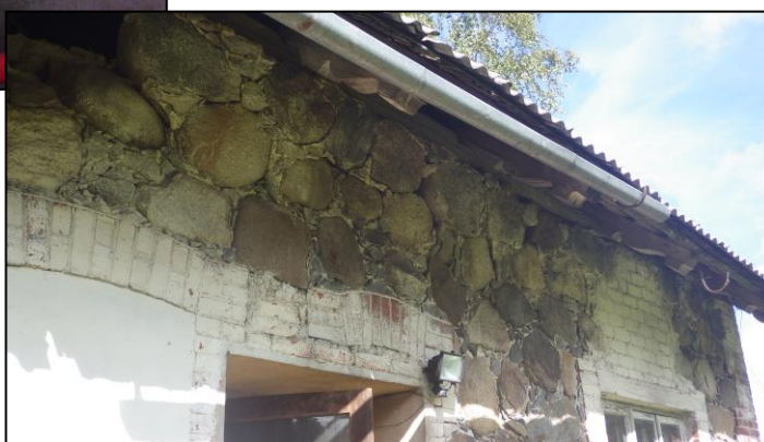
<17> 4. att. ▶ No laukakmeņiem veidotie mūri stipri fragmentēti
