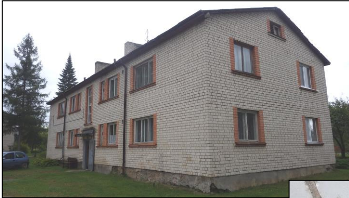
◀ <04> 1. att. Nama kopskats no ziemeļaustrumiem
