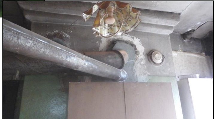
<08> 2. att. ▶ Situācija ar dūmgāzu aizvadcauruļu stāvokli dažviet rada bažas
