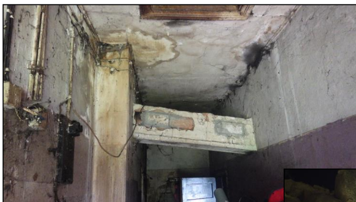
◀ <17> 3. att. Skats ēkas iekšpusē (fragments)
