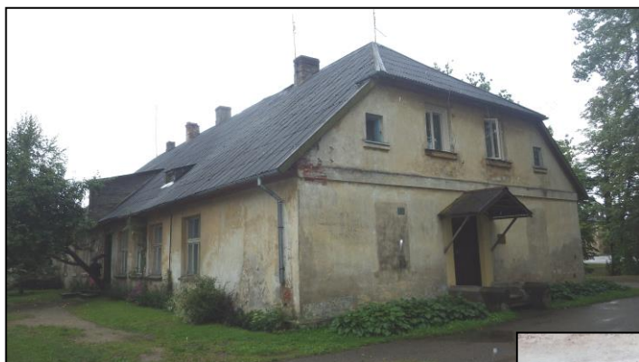
<10> 2. att. ▶ Fasāžu mūra korozija
