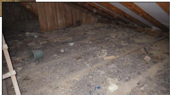
<06> 4. att. ▶ Bēniņu pārseguma siltumizolācija mazefektīva
