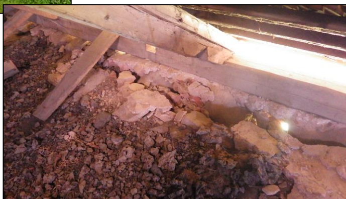
<17> 2. att. ▶ Dienvidaustrumu pusē lokāli atbīdījies ārējas iecirknis (bīstams)
