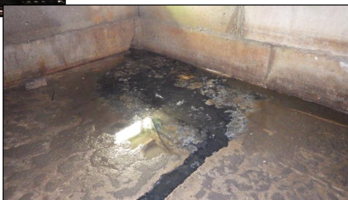
<01> 4. att. ▶ Pagrabā vērojams pastāvīgs grīdas līmeņa appludinājums
