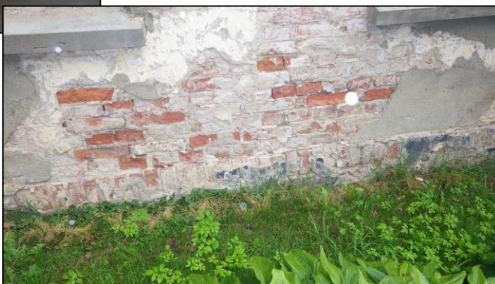
<10> 2. att. ▶ Fasāžu mūra korozija
