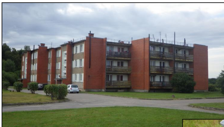
◀ <20> 1. att. Ēkas kopskats no ziemeļrietumiem
