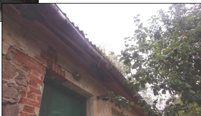
<10> 4. att. ▶ Jumta malās esošās savācējteknes (kur tās vēl ir) gadiem nav tīrītas
