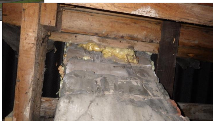
<09> 2. att. ▶ Jumta koka konstrukcijas bēniņos kontaktējas ar mūra dūmvadiem
