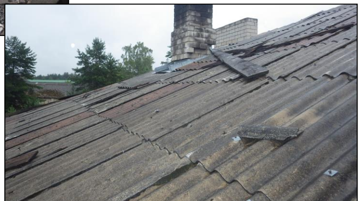
<08> 4. att. ▶ Jumts netiek pienācīgi kopts un uzturēts
