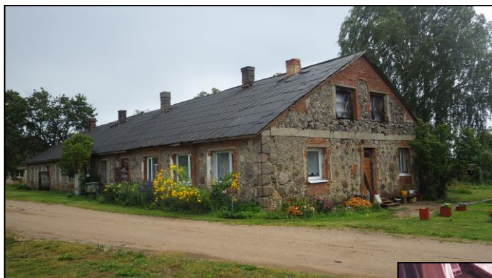
◀ <11> 1. att. Ēkas kopskats no ziemeļrietumiem
