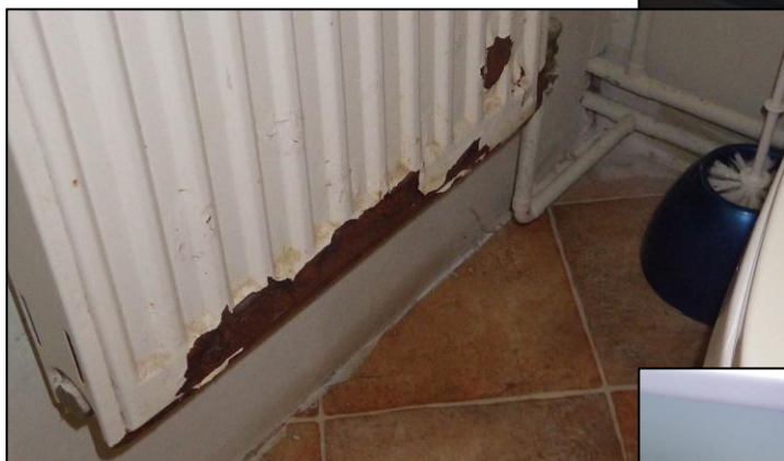
◀ <18> 3. att. Dušas telpā apsildes sistēmas elementa korozija
